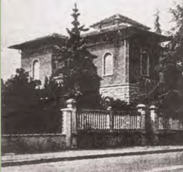
La photo du siège de l'Institut Ouvrières de Marie Immaculée et de la Maison d'Éditions Civiltà, rue G. Galilei 121 – Brescia, telle qu'elle a été publiée pendant des années sur "Chiesa viva".
